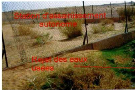
Photo 2 : Rejet des eaux usées a ciel ouvert (2008)
